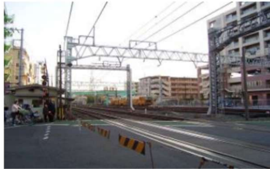
踏切障害事故 《死者2名、負傷者2名》
