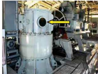
減速機の検査窓
