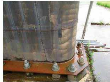
錆が見られ始めたアンカーボルト周辺
