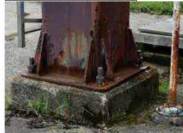
錆が見られ始めたアンカーボルト周辺
