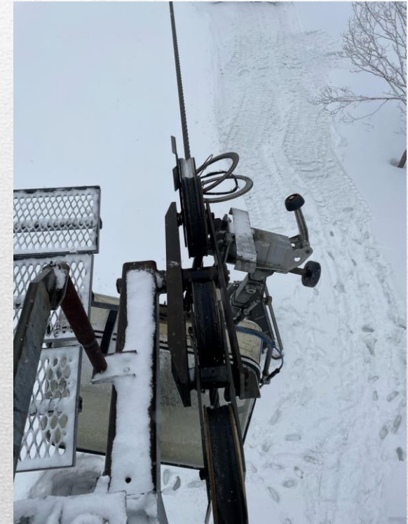
事故写真(索輪破損、ロープ断線・摩滅)
