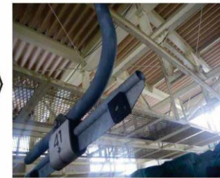
破断したフレーム
