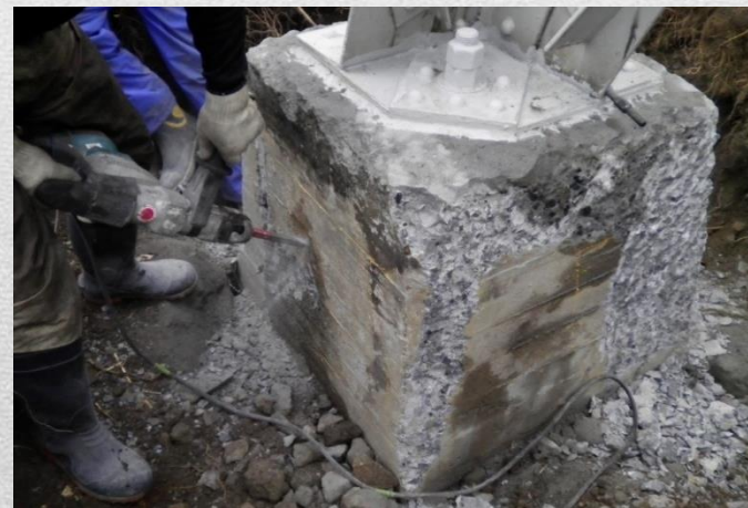
支柱基礎修繕作業
