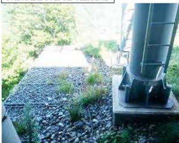
砕石構造とした支柱の基礎部分
