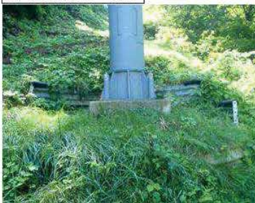
砕石構造とした支柱の基礎部分
